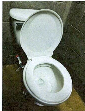
Foto 2: Mejoramiento de los baños, puertas, accesorios y la instalación de red de agua.
