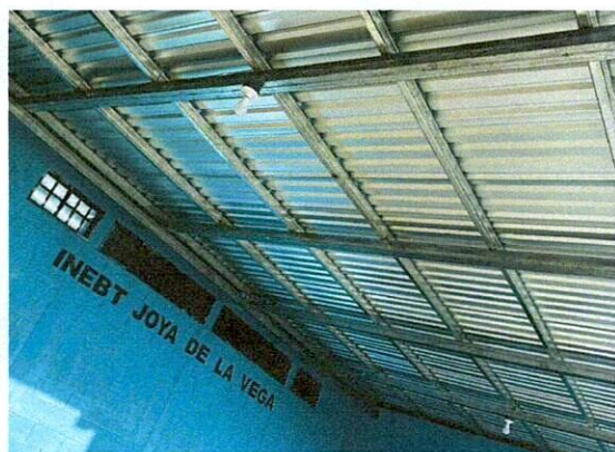
Foto 1: Instalación de techo con estructura de metal y cobertura de lámina troquelada calibre 26 en el patio.
